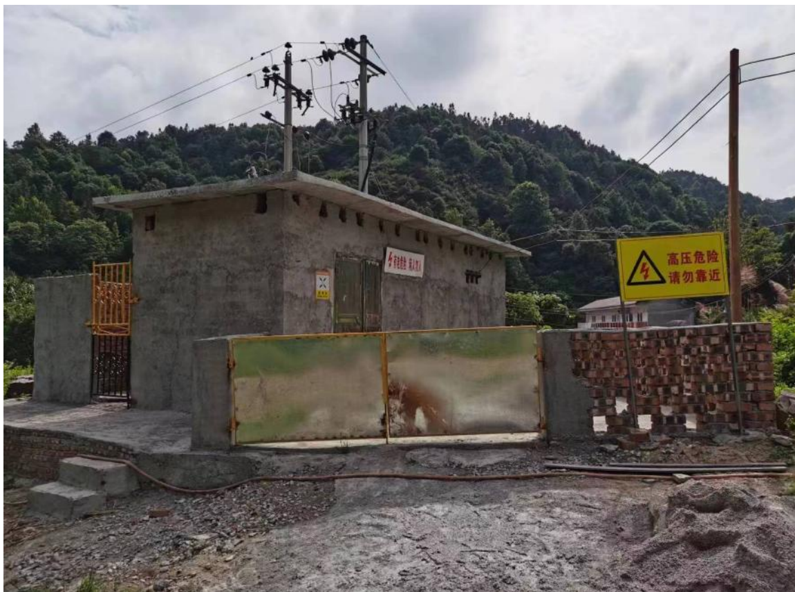
地面变配电所
